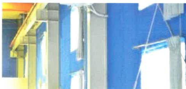
吸音材施工事例 (工場)
